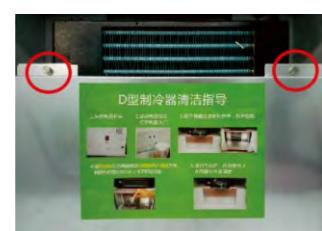
Nota: Ao limpar o evaporador, preste atenção para não deixar a sonda de temperatura tocar o radiador e a parte interna de metal do evaporador. Deve ser fixado na placa contendo água para evitar afetar a temperatura de armazenamento refrigerado.
